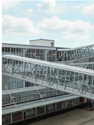
Van Nellefabriek, Rotterdam, Brinkman & Van der Vlugt
